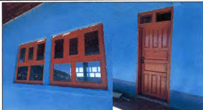
Foto1: Aula 1: Sustitución de Ventana de madera por meal más vidrio y Sustitución de puerta.
