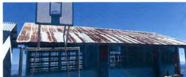
Foto 4: Módulo de Aulas 3 y 4: desinstalación de lámina existente; sustitución de lámina, por lámina troquelada aluzinc calibre 26 e instalación de canales.
